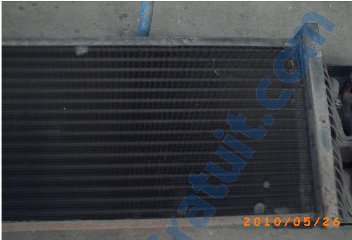
Figure (I.4): Le condenseur de l'installation.
