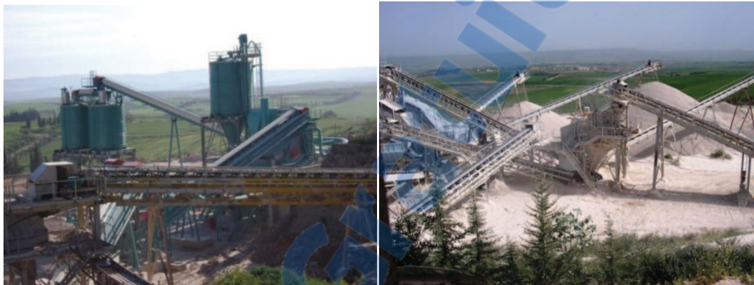
Figure II.9. Vue Générale de la station de Sidi Abdelli
