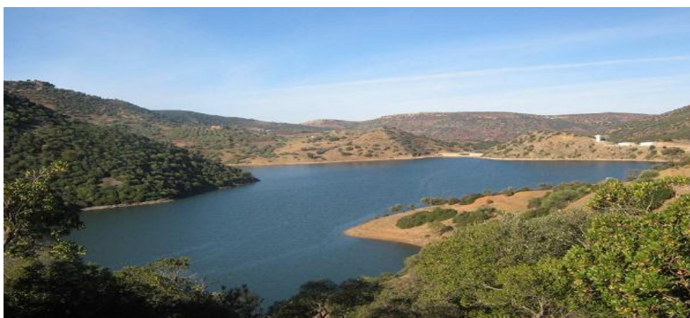
Figure 1 : image du barrage de BAB LOUTA
