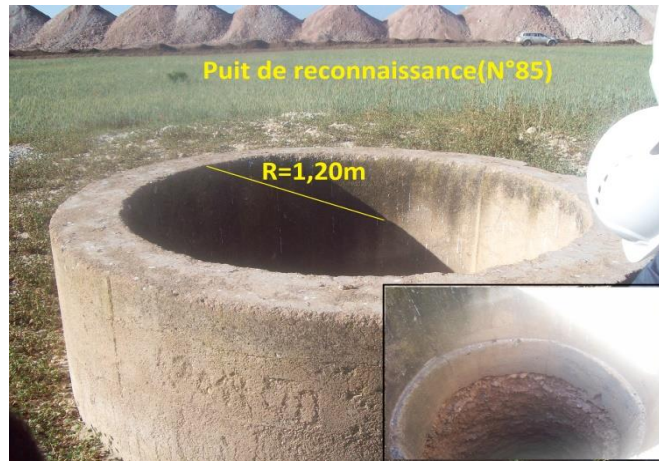
Figure II.13 : photo d'un puits
