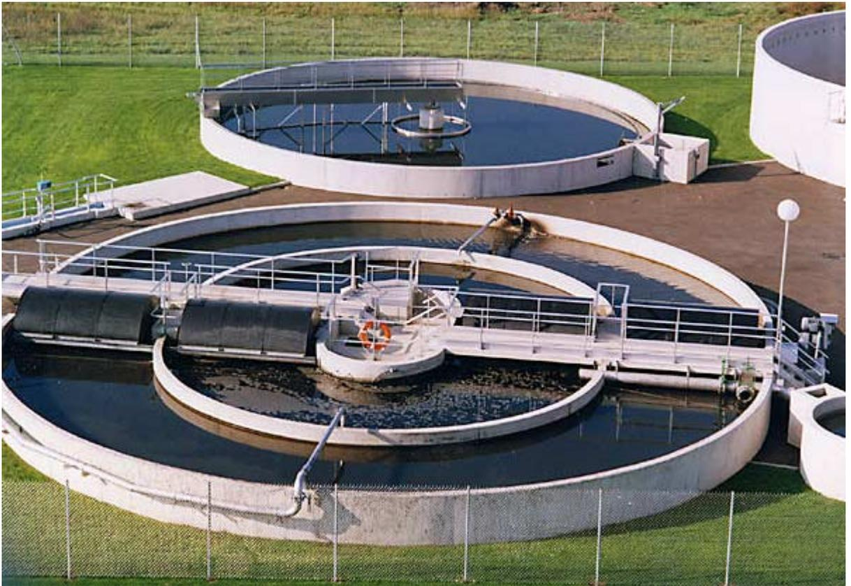
Figure 6 : Dégraisseur – dessableur aéré (Cliché Alpha)
