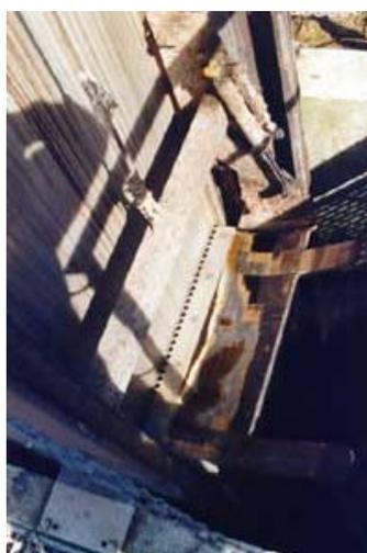
Figure 2 : Dégrilleur à grille droite à nettoyage alternatif (cliché Honet)
