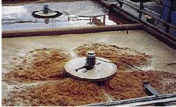
Figure 9 : Réacteur aérobique à boues activées et aération de surface (cliché Aaqua Waste Water Technology)
