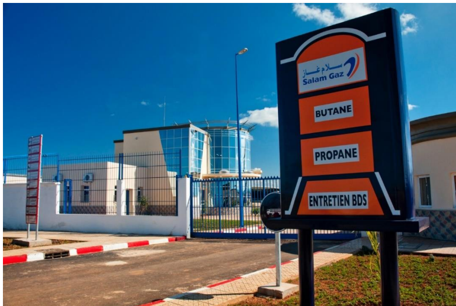
Figure 1 : centre emplisseur Fès/Meknès.
