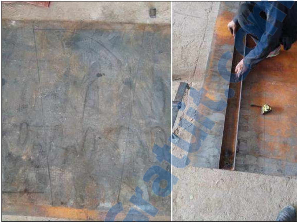
Fig.3.1.Traçage des tôles
