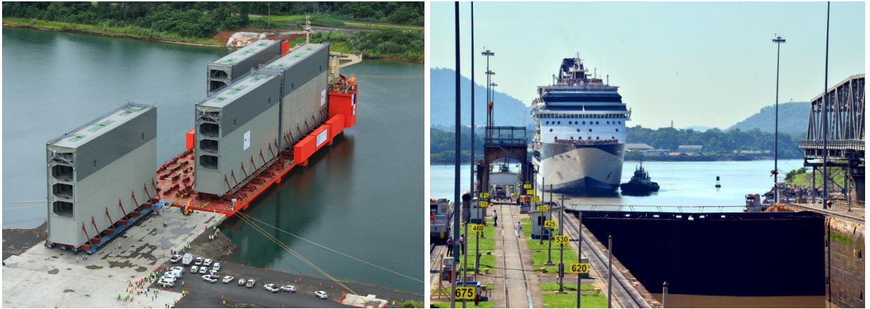
Figure 1.8 : Porte mécanique d'écluse immergée dans l'eau (MERETMARINE).
