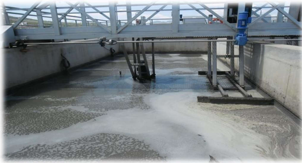
Figure 8 : dessablage-déshuilage
