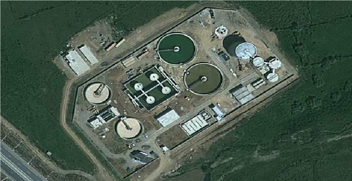
Figure 3: Image satellitaire de la station d'épuration Tamuda Bay
