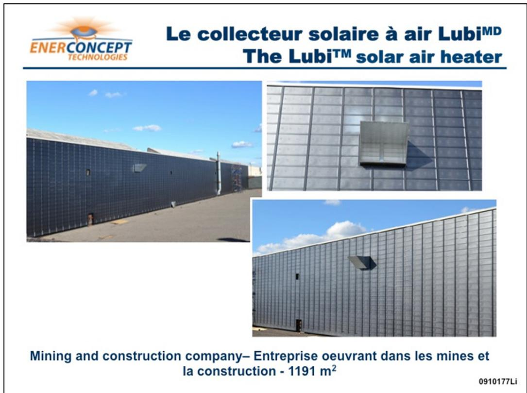
Figure 1.9 Exemple d'installation de TTC tiré de (Enerconcept, 2013)
