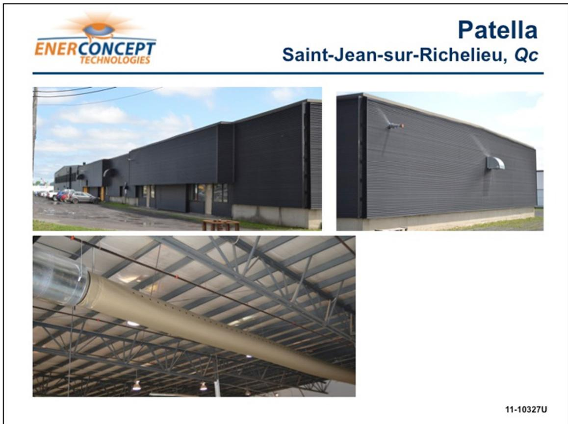
Figure 1.7 Exemple d'installation d'un UTC tiré de (Enerconcept, 2013)
