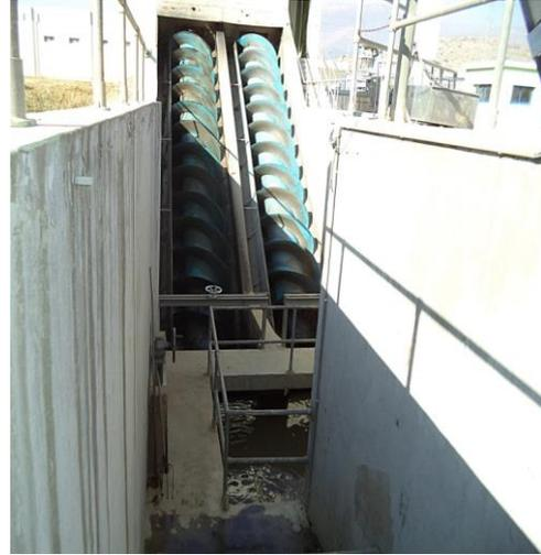
Figure III.04: Photo vis d'Archimède.
