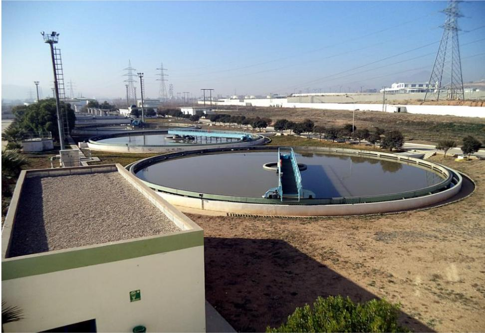
**Figure III.10** : Décanteurs secondaires (Clarificateurs).
