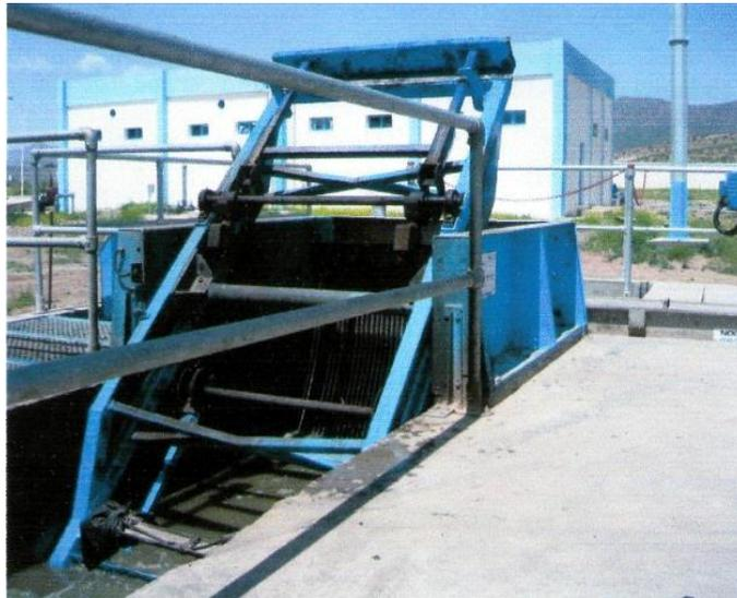
Figure III.05 : Photo du dégrilleur mécanique.
