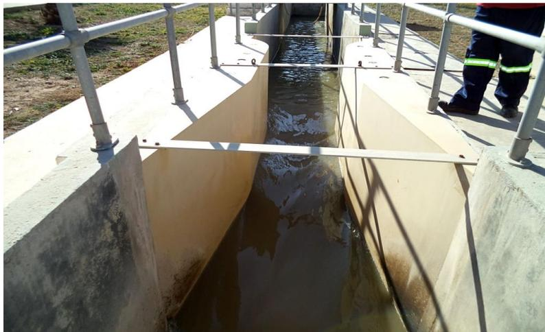
**Figure III.11** : Canal de comptage et de mesure (eau épurée)
