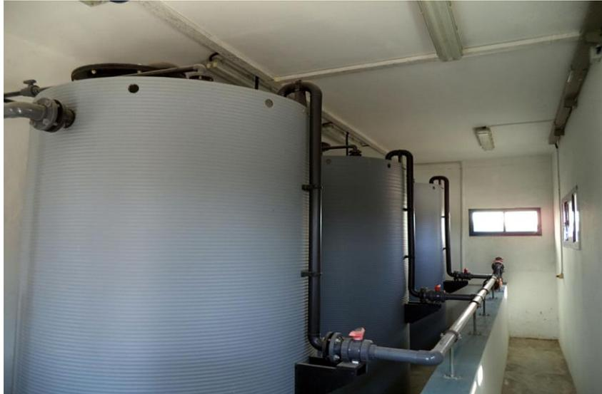
**Figure III.12 :** Photo de la station de dosage d'hypochlorite de sodium
