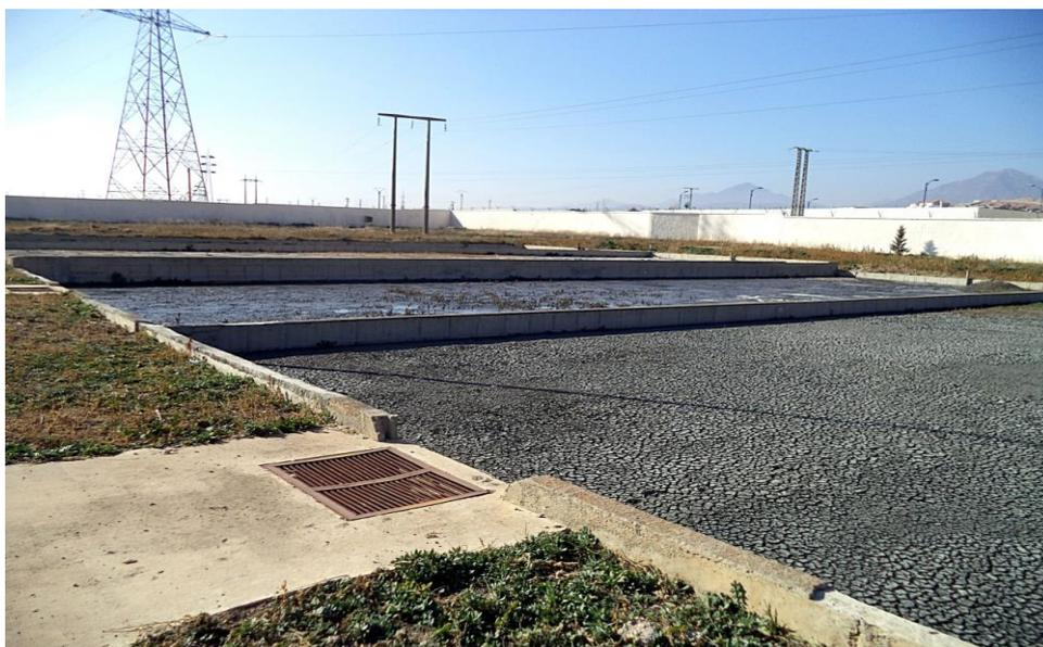
**Figure III.16 :** Photo des lits de séchage des boues
