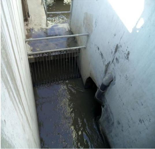
Figure III.03 : Photo Pré-dégrillage grossier
