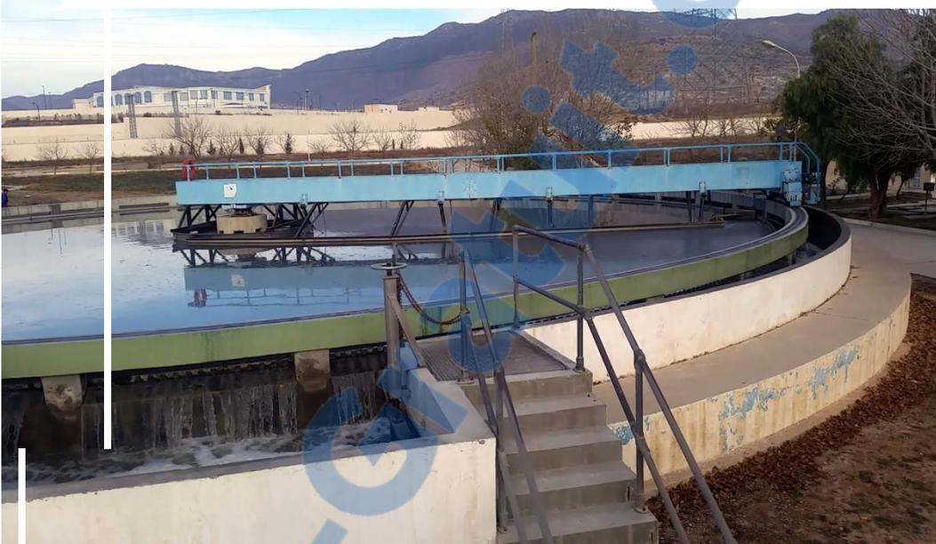
**Figure III.08 :** Photo du décanteurs primaire.
