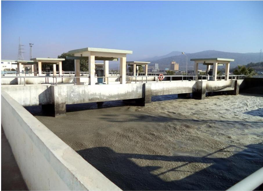
**Figure III.09** : Photo du bassin d'aération.
