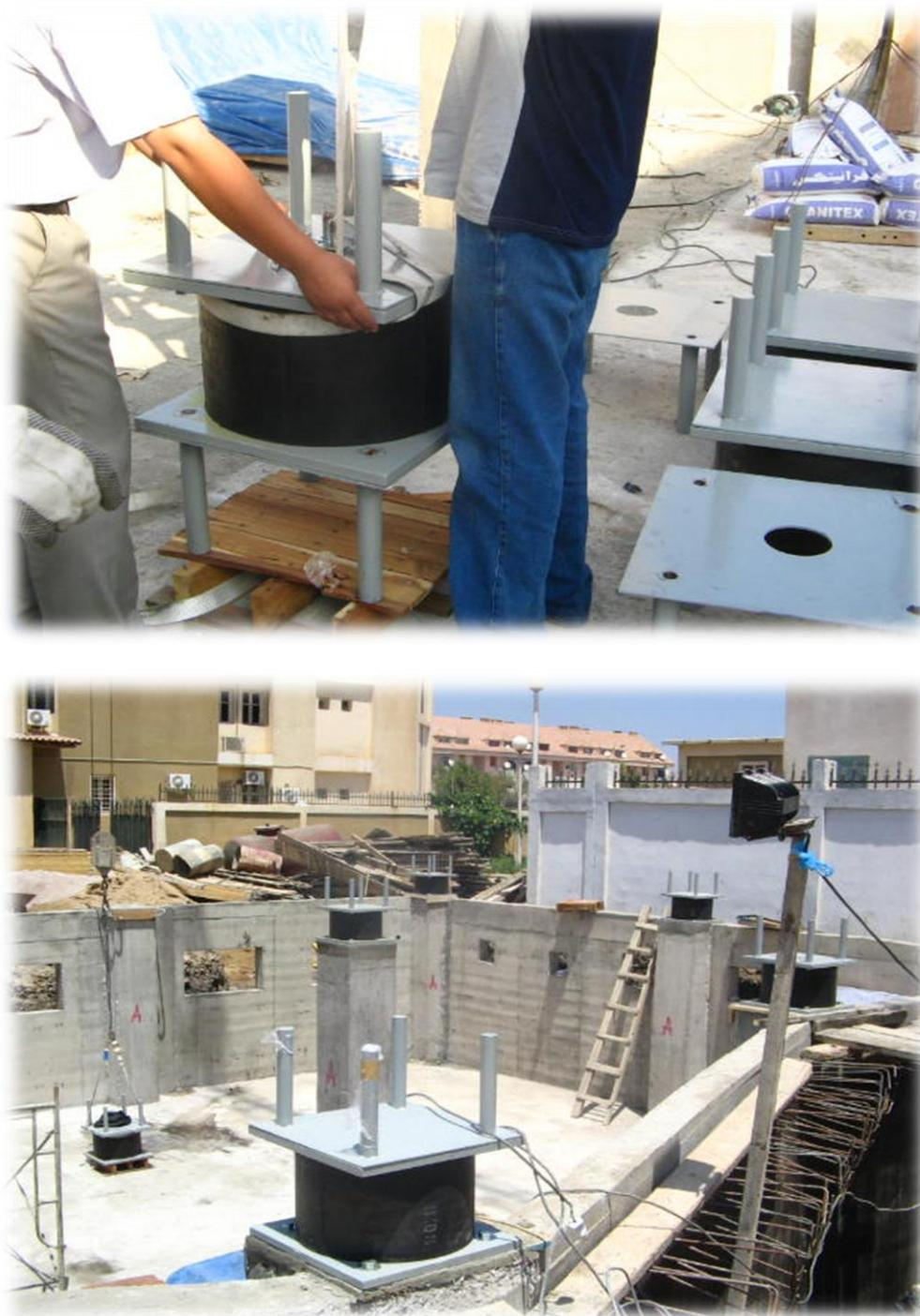
Figure I.12. Installation des dispositifs parasismiques [11]
