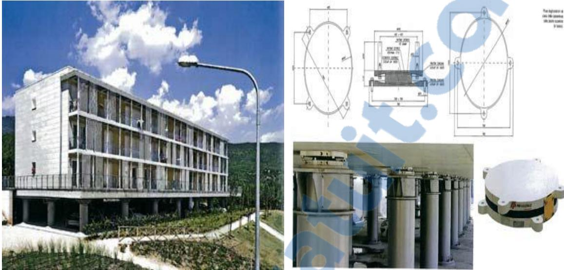
**Figure I.9.** Aquila bâtiments du quartier et le système de pendule de frottement utilisés
