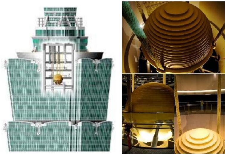
**Figure II.12.** Un TMD pendulaire de 800 tonnes dans un bâtiment de 508 m de hauteur (tour de Taipei 101)
