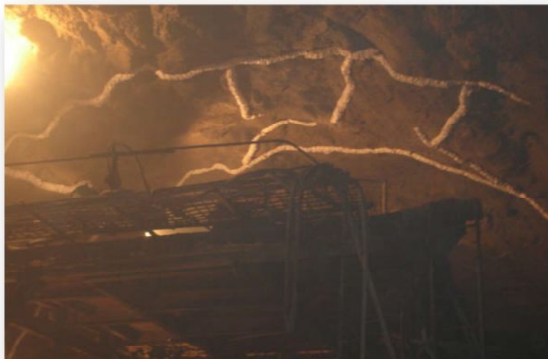
Figure 3.34 Système de collecte d'eau installé en site (Li et al., 2009)
