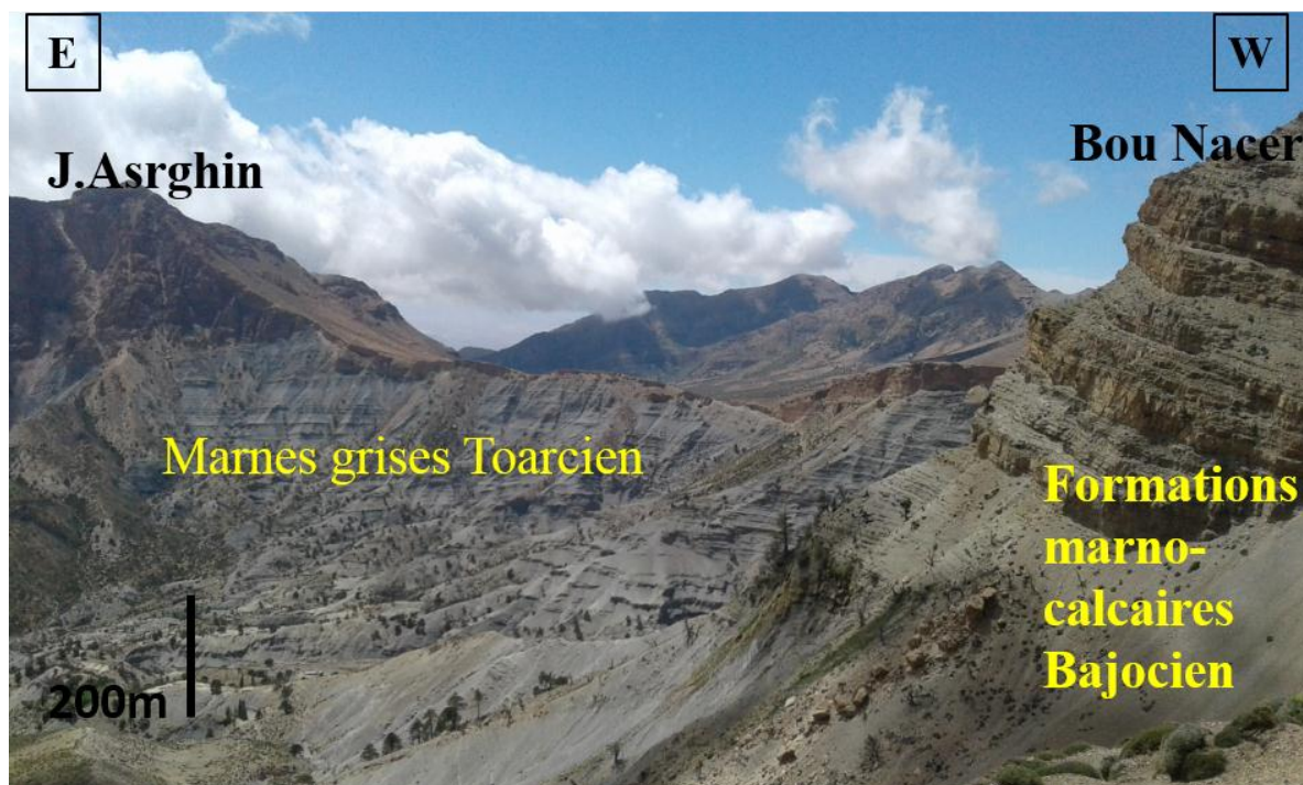
Figure 13 : Vue vers le SE de la ride de Bou Nacer (Photo du Terrain 12/05/2017).
