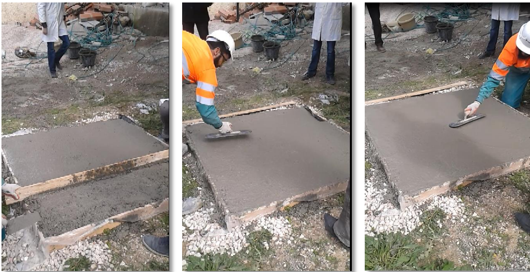
Figure 1. 4. Nivelage et lissage de la surface du béton coulé (photos prises par les auteurs)
