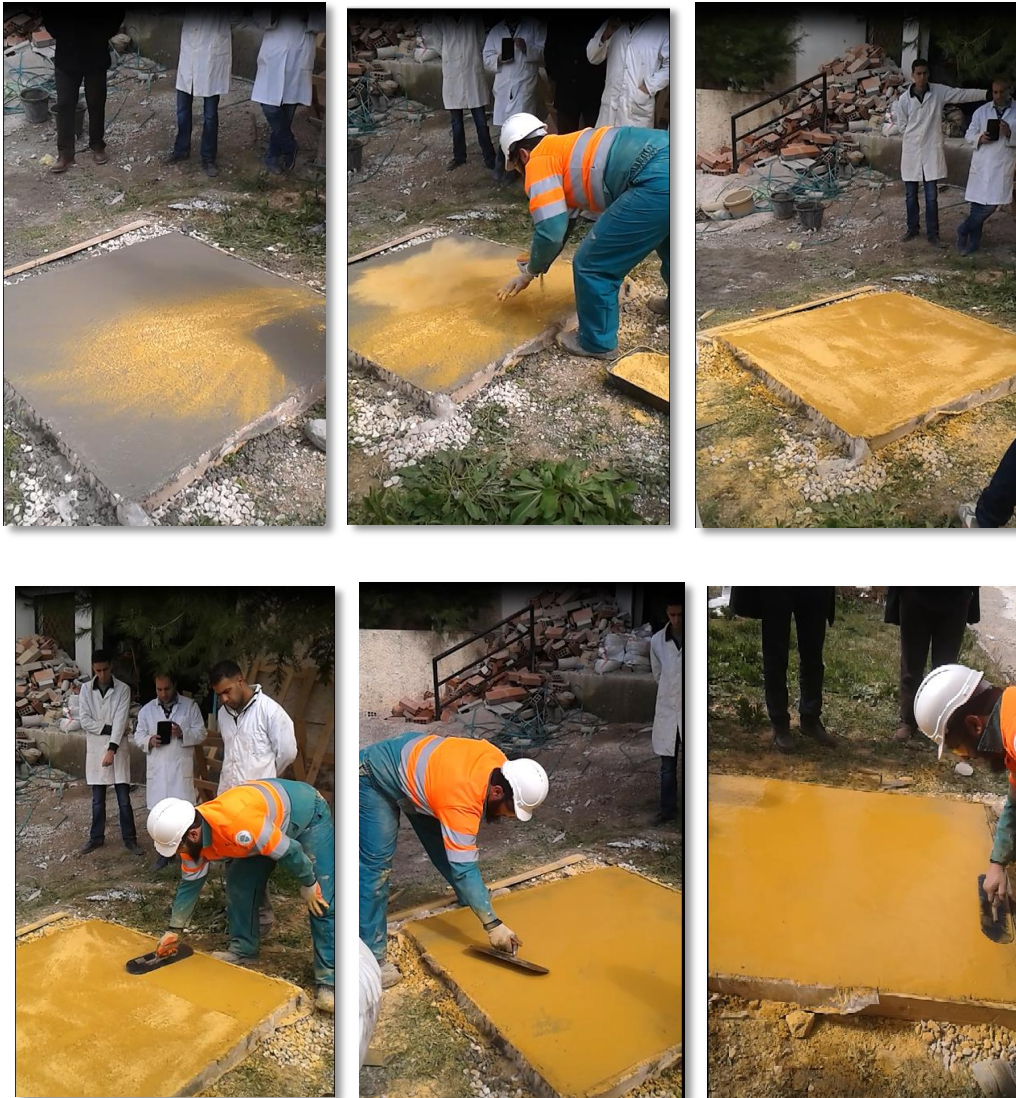
Figure 1. 5. Epannage et lissage du colorant en surface (photos prises par les auteurs)
