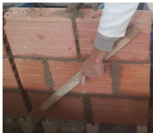
Figure 3.19 : Vérification de la planéité du mur avec la règle en bois (photos prise par les auteurs)
