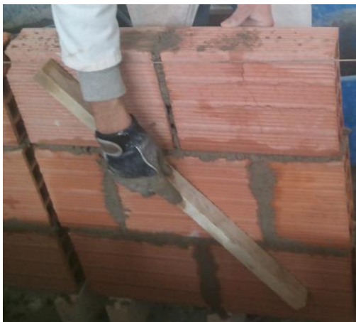
Figure 3.19 : Vérification de la planéité du mur avec la règle en bois (photos prise par les auteurs)
