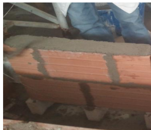
Figure 3.17 Etalement du mortier (photos prise par les auteurs)
