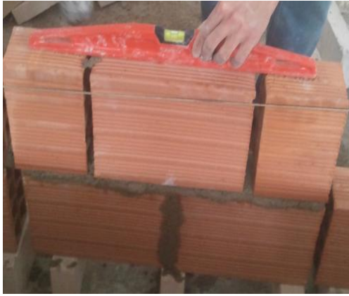
Figure 3.18 : Vérification de la planéité à l'aide du niveau à bulle (photos prise par les auteurs)
