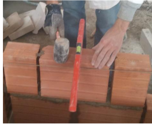
Figure 3.18 : Vérification de la planéité à l'aide du niveau à bulle (photos prise par les auteurs)
