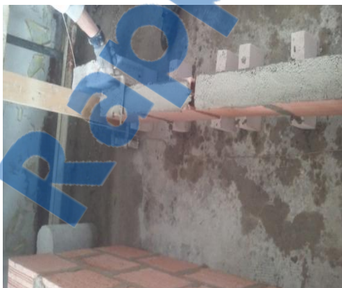
Figure 3.17 Etalement du mortier (photos prise par les auteurs)
