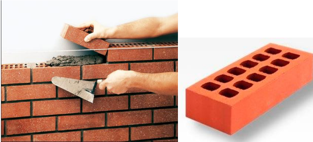
Figure 1.6: Mur en briques perforées ( www.wienerberger.fr )
