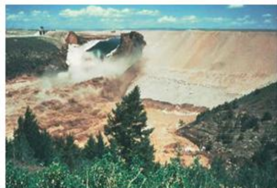
Rupture du barrage de Teton (USA)
