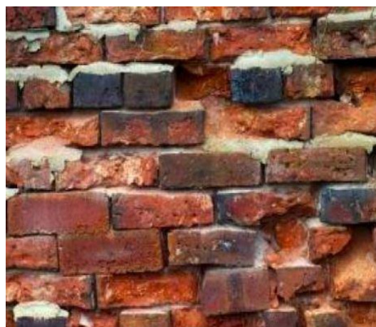
(b)- dislocation et émiettement de la brique.
