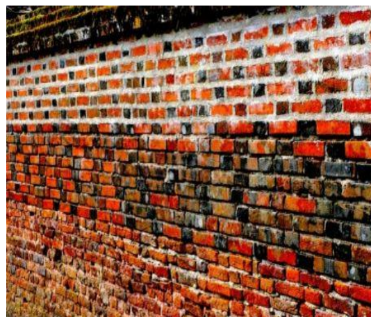
(d)- Nettoyage par micro-sablage et hydro-gommage.
