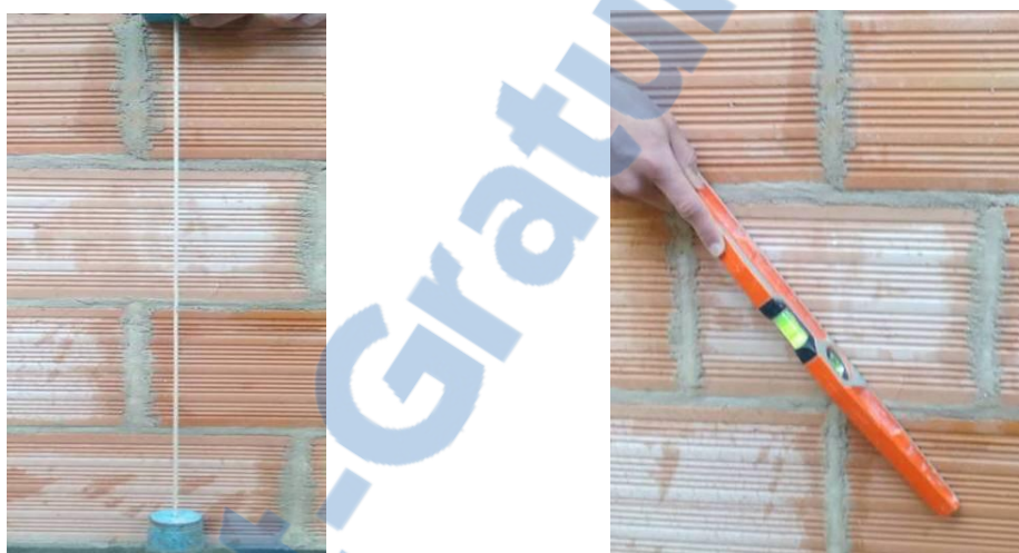
Figure 3.34 : Vérification de la planéité à l'aide d'un fil à plomb et du niveau à bulle.
