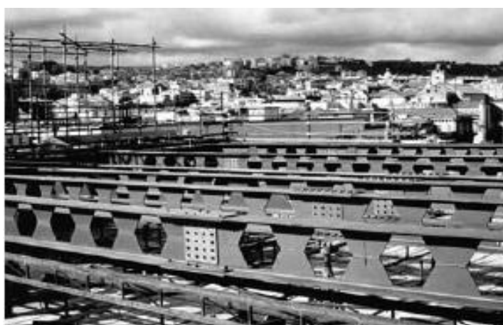
Figure 1.11 : Poutres alvéolaires
