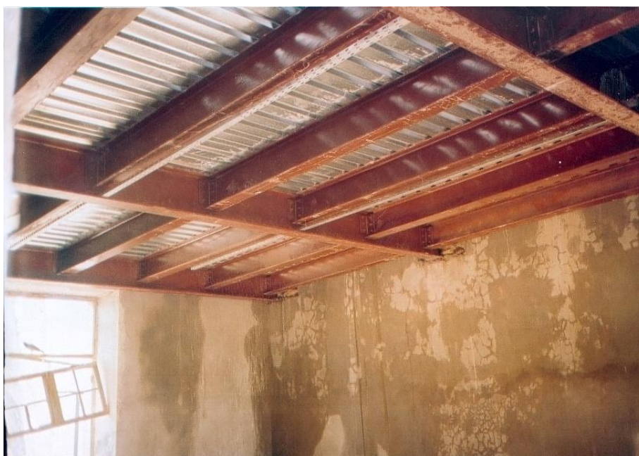
Figure 1.31 : Poutrelles métalliques reliées aux poutres
