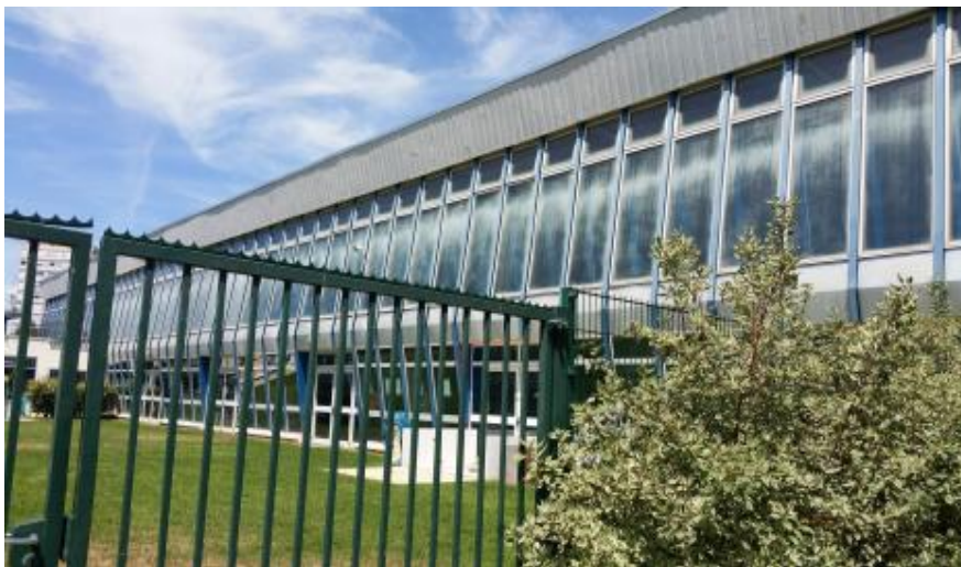
Figure 2.12 : Photo de la façade conservée (coté piscine)
