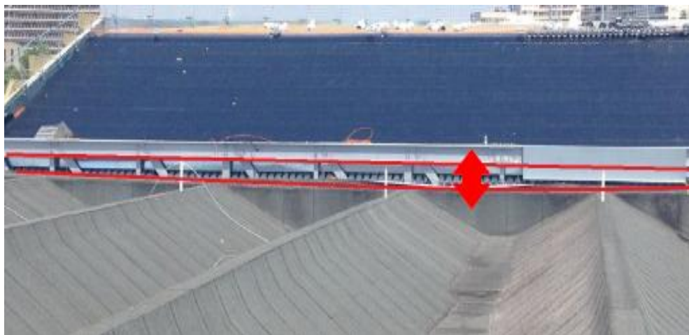
Figure 2.10 : Photo de la flèche prise par la toiture
