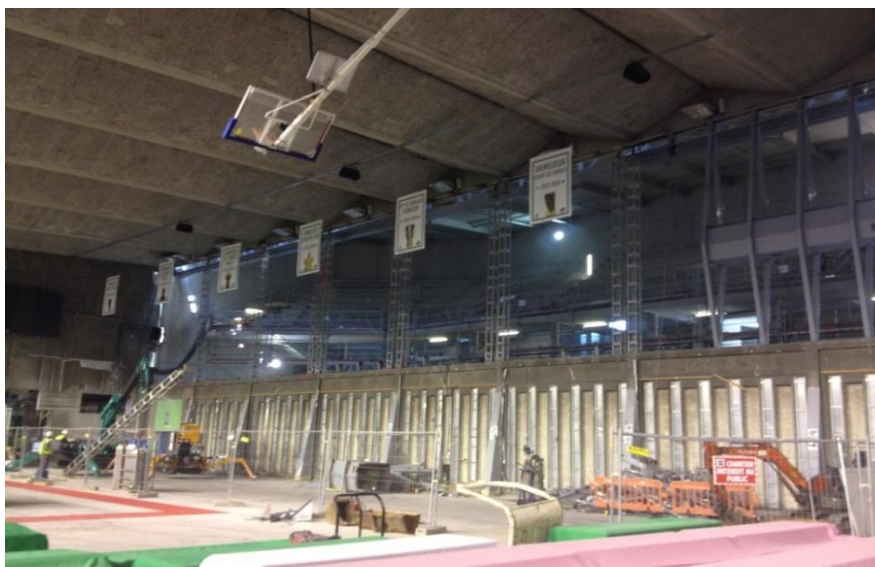
Figure 2.13 : Photo de l'étalement en sous face
