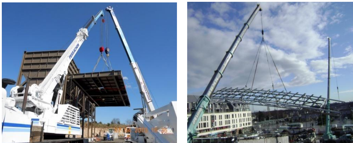
Figure 1.12 : Facilité de surélever une structure métallique
