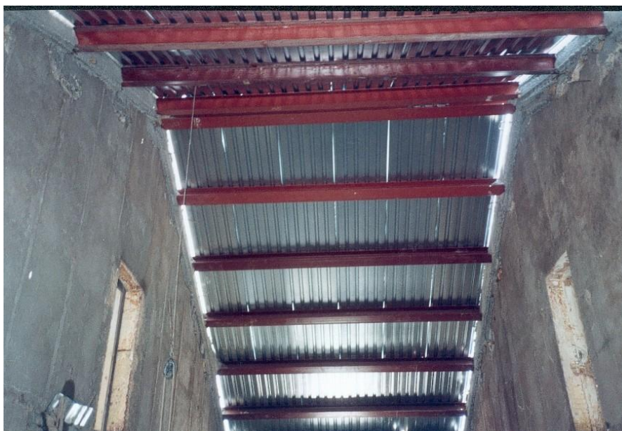
Figure 1.30 : Poutres principales ancrées aux murs porteurs
