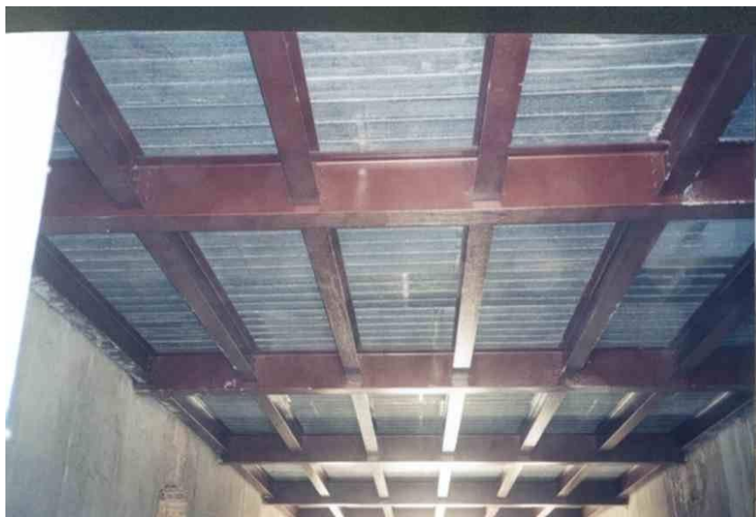
Figure 1.32 : Tôle nervurée métallique posée sur le quadrillage
