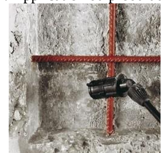
Figure 4.19 : Humidification des armatures
