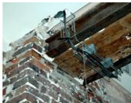
Figure 1.2 : Poutres en bois renforcées avec de l'acier
