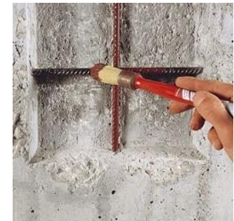
Figure 4.18 : Application du produit anticorrosion
