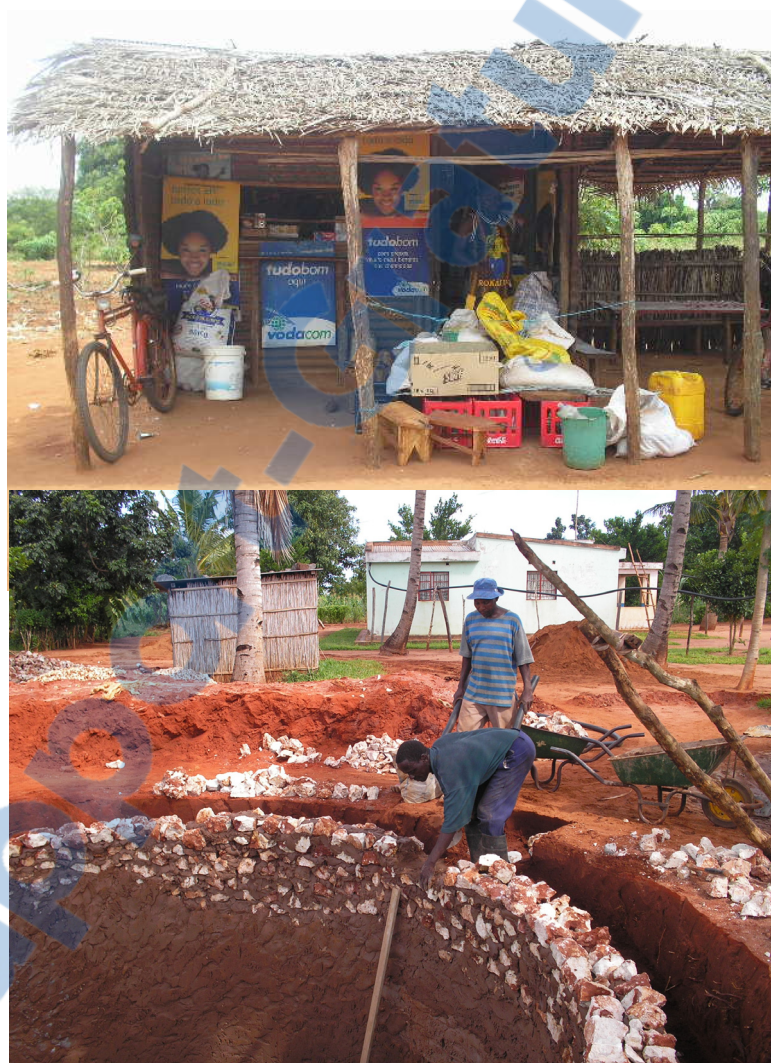
Photos 6 et 7 : construction d'un réservoir d'eau réalisé par un ménage avec stratégie de type 3 pour une famille de type 4 (bas) et boutique de commerce de produits de base (haut).
