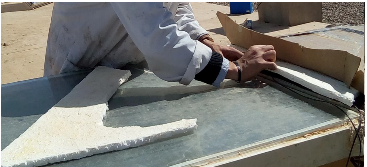
Figure IV.5 Placement de l'isolation (polystyrène)
