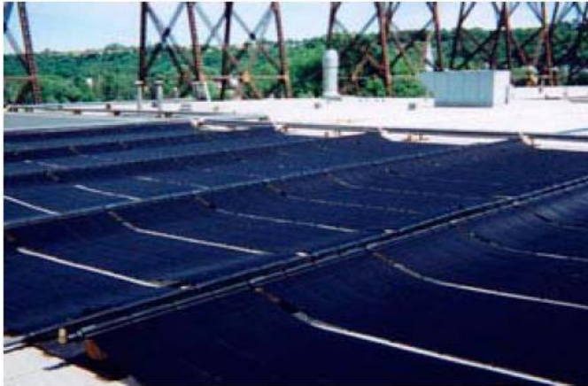
Fig.II. 2: Capteur solaire moquette.
