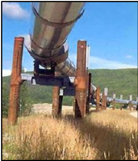
Figure I.2: Canalisation aérienne [9]
