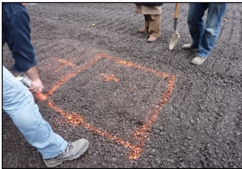
Figure 3.5 Excavation d'une surface d'environ 1\text{m}^2 jusqu'à la profondeur prédéfinie pour le positionnement de la sonde d'humidité
