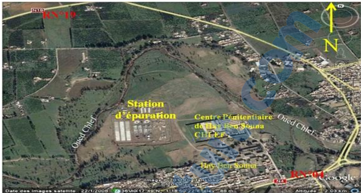
Figure IV.2: Localisation de station d'épuration des eaux usées (STEP) de Chlef (Source: Google earth.29/03/2011)
