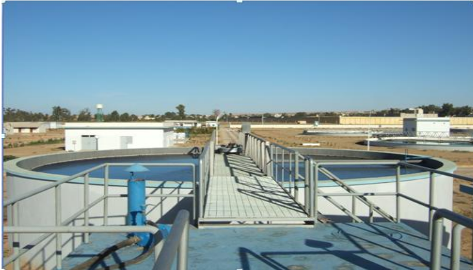
Figure IV.8: Photo d'un Epaisseur (ONA.2011).
