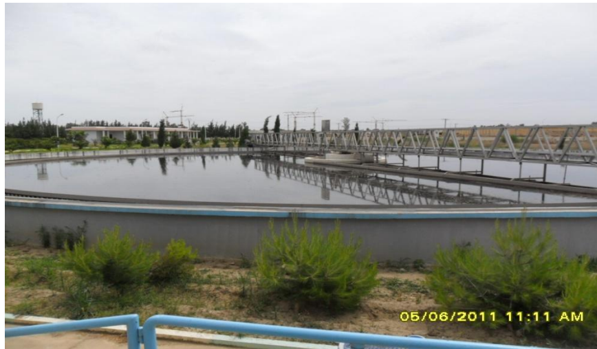
Figure IV.7: Photo du bassin de clarificateur (ONA.2011)
