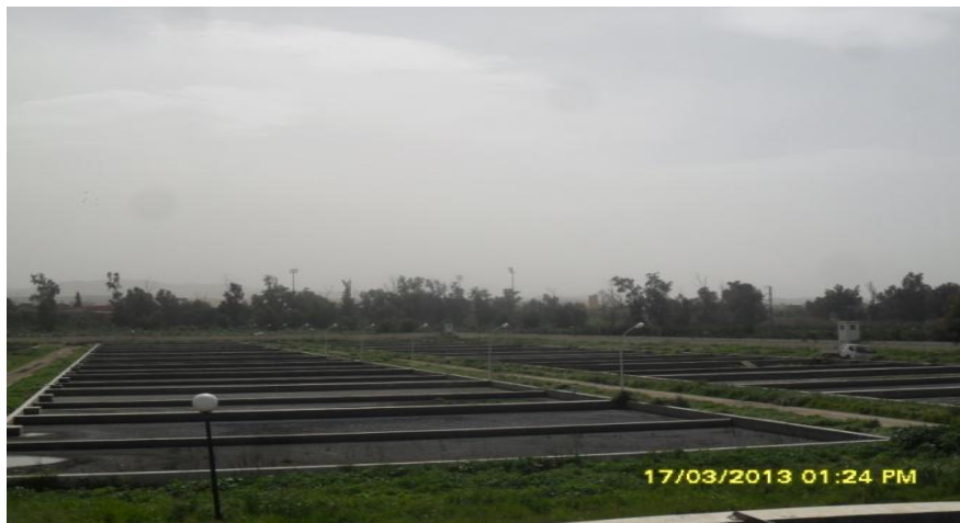
Figure IV.9: Photos de lits de séchage (ONA.2013)
