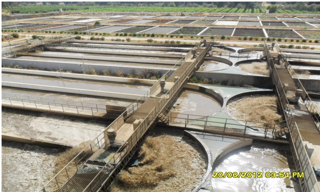
Figure IV.6 : Photo du bassin d'aération (ONA.2011).
