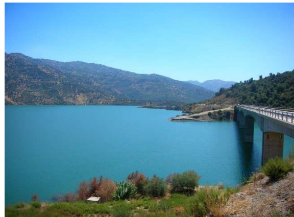
Figure. 2 : Barrage Taksebt (Tizi Ouzou)
