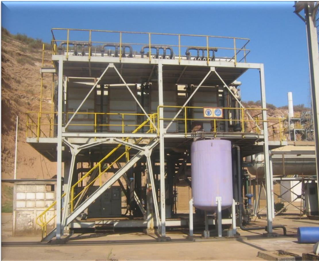
**Figure III.14:** Station de dessalement
