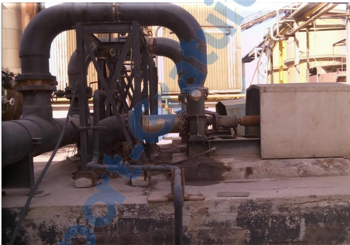
**Figure III.18:** Pompe d'eau de mer au niveau de dessalement
