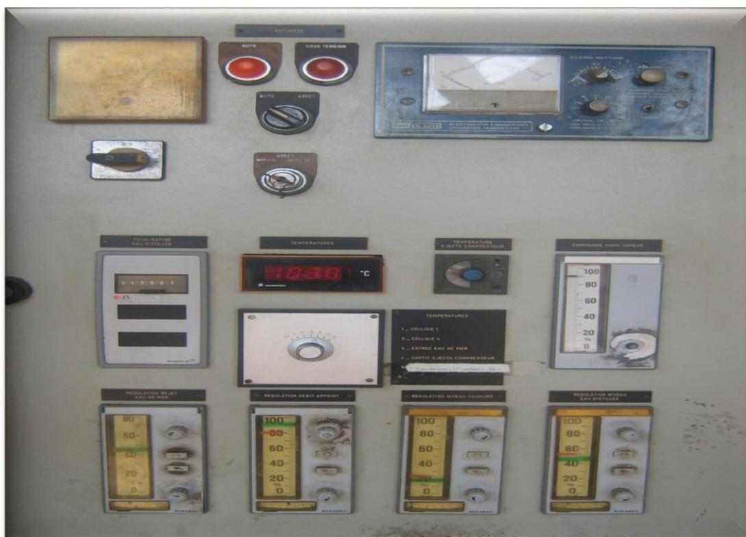
**Figure III.23:** Armoire électrique + le système d'alarme pour signaler les défauts de fonctionnement.
