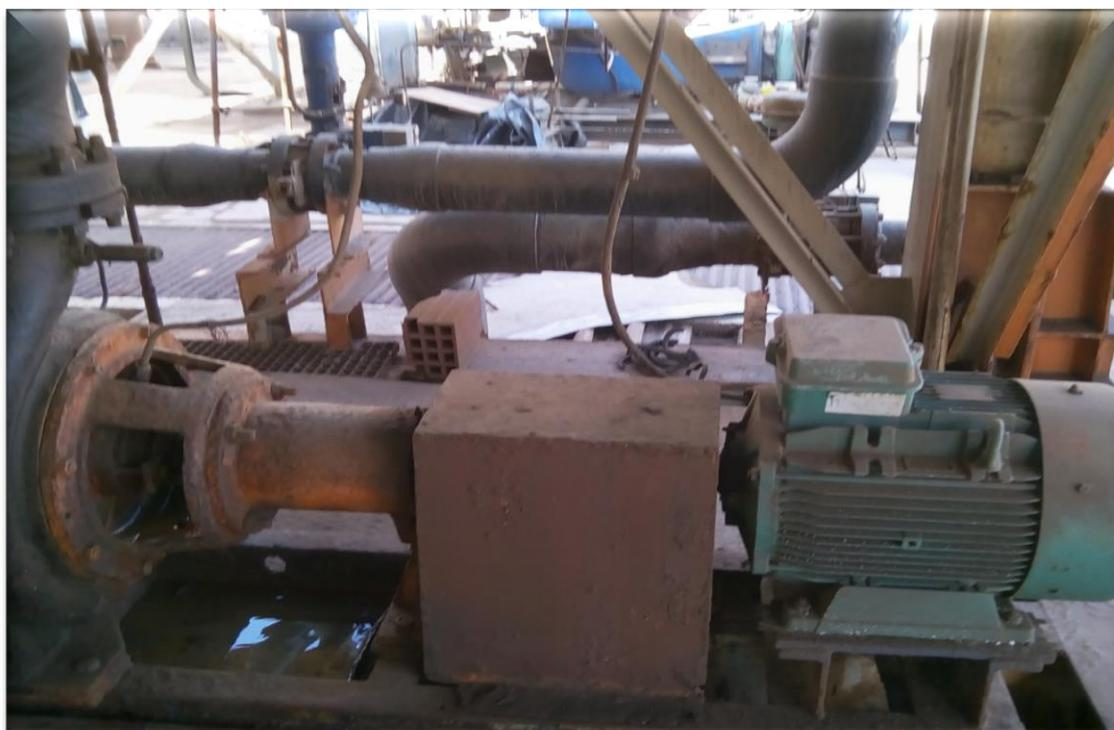
**Figure III.19:**Pompe centrifuge d'eau saumure
