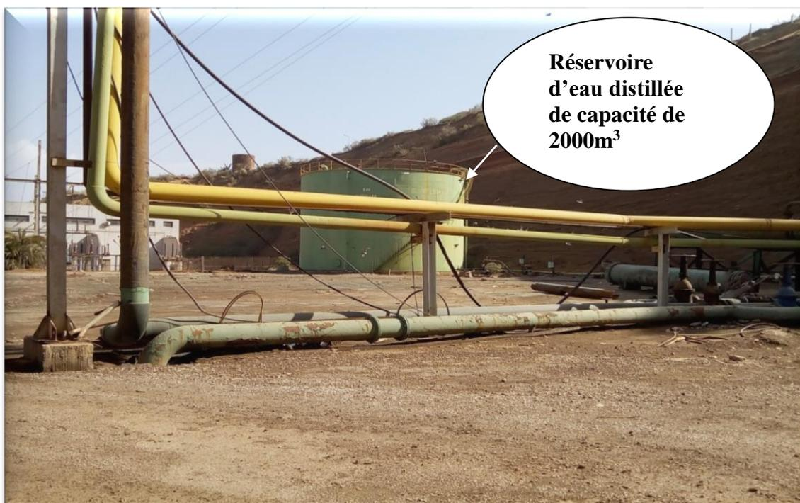
Figure III.26: Stockage de l'eau distillée
