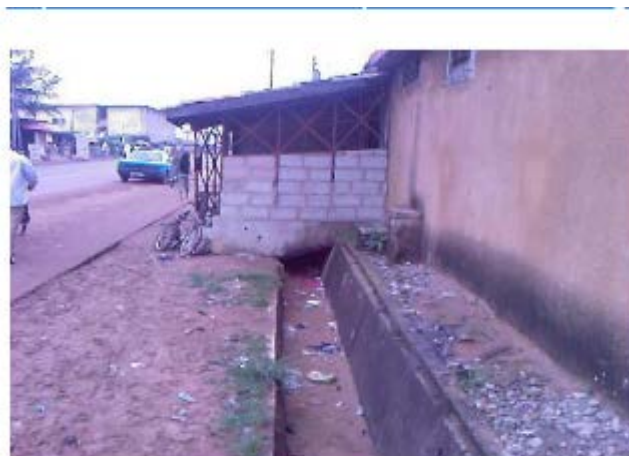
Figure III.12 : Construction sur un caniveau.
