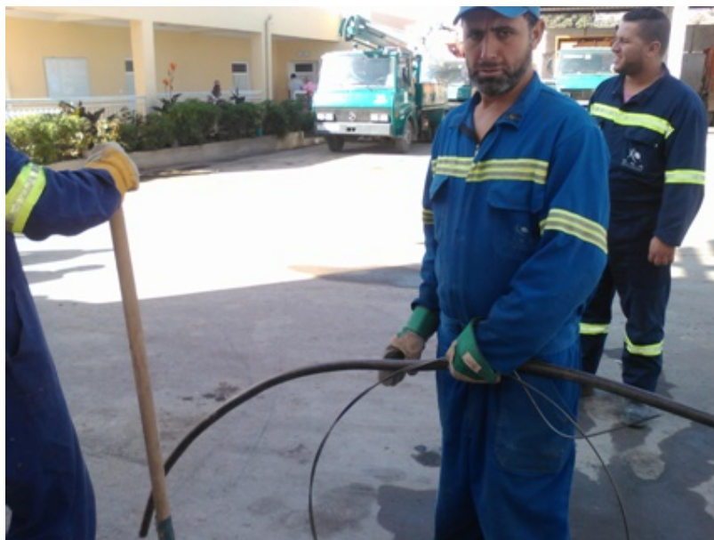
Figure III.22 : Acier de débouchage.
