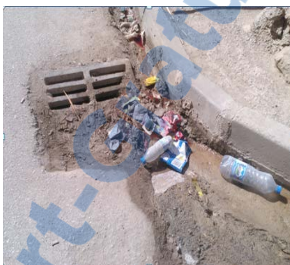
Figure III.11 : Fermeture des avaloirs dans Hai Zitoune.
