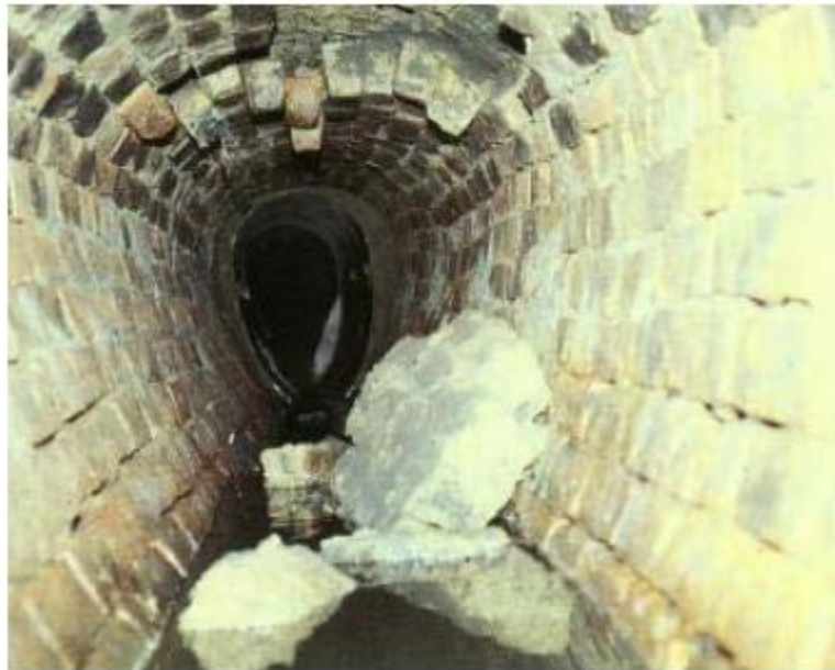
Figure II.3 : Exemple d'obstruction [15].
