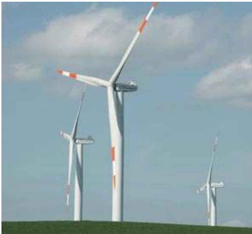
Figure 3.4 Éolienne Nordex N80.
