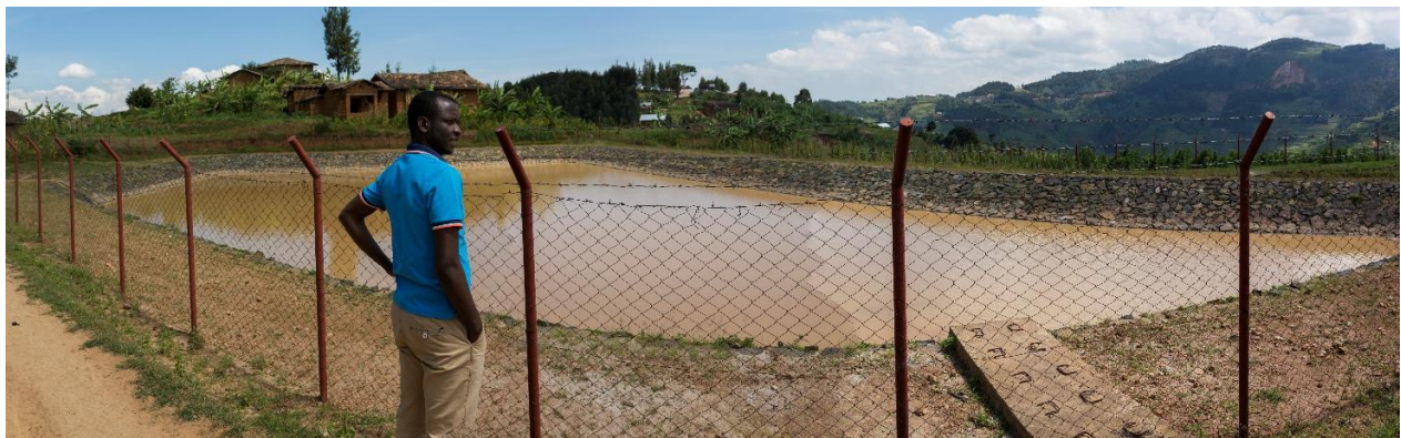
Photo 9 : Bassin de stockage pouvant être utilisé comme second dessableur et bassin de mise en charge
