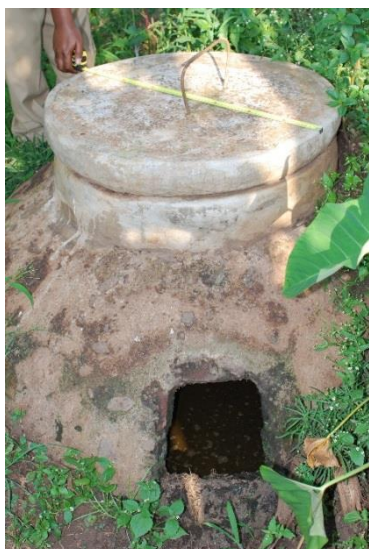
Fig. 14: chambre d'évacuation d'un digesteur, avec au sommet l'ouverture permettant l'accès au digestat et au premier plan la sortie du trop-plein et le menant au bassin de rétention. Photo prise le 04.06 sur la propriété de Félicien FASHAHO.
