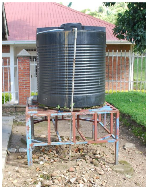
Fig. 24: réservoir à eau de 2 m 3 , tel qu'utilisé au Rwanda pour recueillir l'eau de pluie. Photo prise le 29.05 sur le site de l'hôpital de référence de Kibuye.
