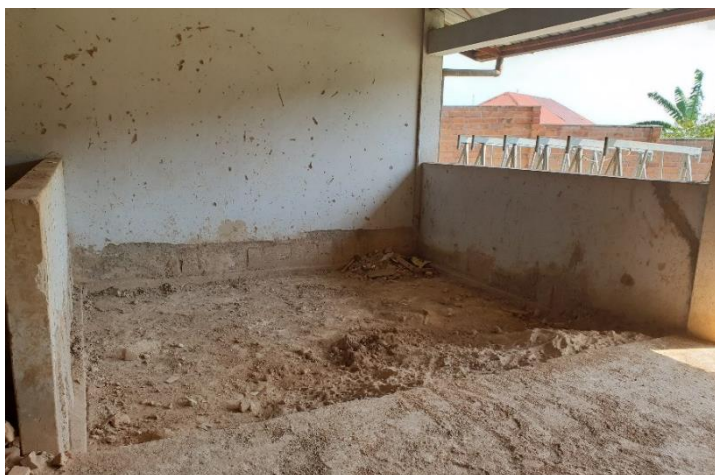
Fig. 19 : box de l'atelier de maçonnerie sur le site de l'IPRC-Karongi, pouvant servir de lieu pour l'implantation d'un laboratoire d'analyse du biogaz. Surface au sol : 5x4m, hauteur de mur env. 1.5 m.
