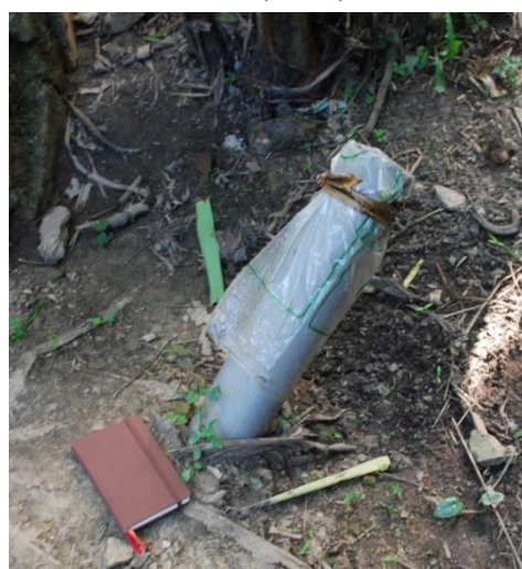
Fig. 15: accès prévu pour l'injection de déjection humaine dans le dôme et scellé en attente de finalisation. Photo prise le 31.05 sur la propriété de Grégoire KABERA.
