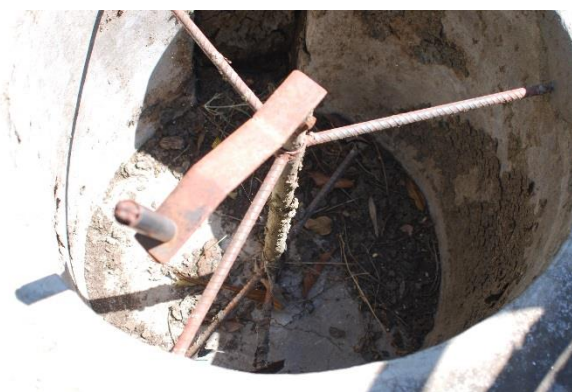
Fig. 12: bras pivotant similaire à un mixeur et permettant le brassage efficace du substrat pour son homogénéisation et avant son injection. Photo prise le 03.07 sur le site de l'église catholique de Kibuye.
