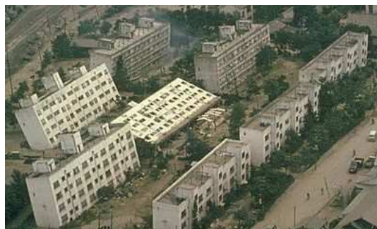
FIGURE 1.13: Barres d'immeuble s'enfonçant dans un sol liquéfié lors du séisme de Niigata 1964 ( http://earthquake.usgs.gov/earthquakes/world/events/1964_0616.php )
