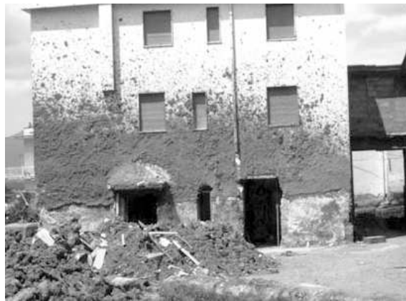
FIGURE 1.12: Marques d'éclaboussures des coulées de boues sur une maison de Quindici (Revellino et al., 2004)
