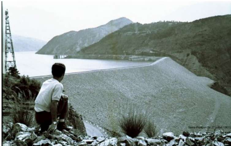
Barrage en terre de Serre Ponçon (Hautes-Alpes)
