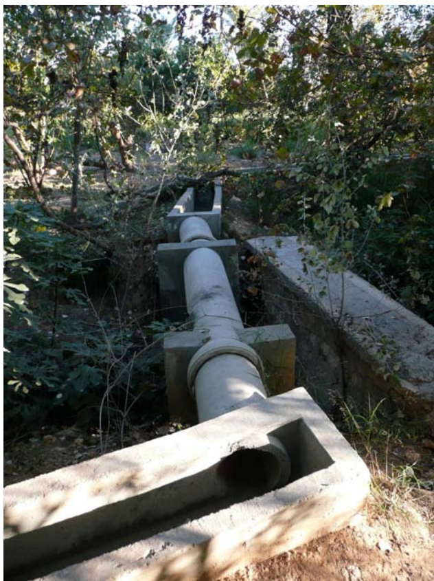
Photo 5. Oasis de Gabès : Canalisations secondaires en béton de construction récente (Photo C. Thenail)
