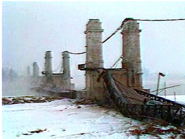
FIGURE 4.10 – Le pont de Sully-sur-Loire après sa rupture brutale du 16 janvier 1985
