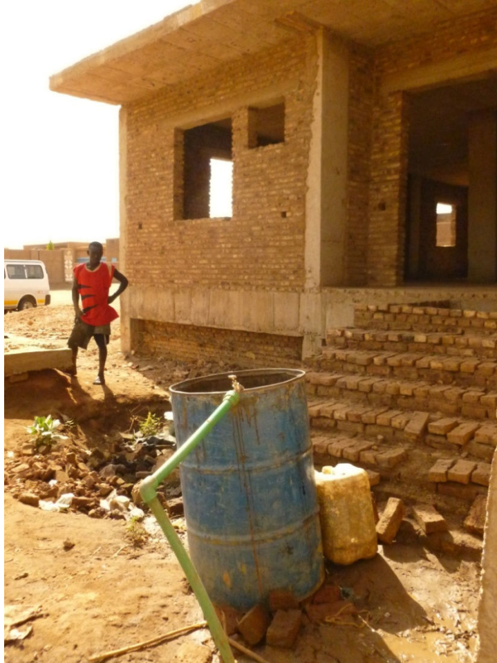
PHOTO 15 : MAISON EN CONSTRUCTION A TUTI. Décembre 2012. L. Arango.
