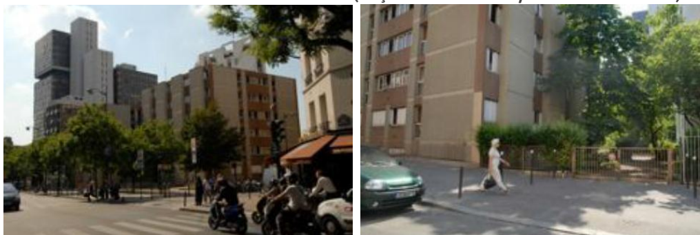
FIGURE 8.1 – PERSPECTIVES SUR LE FOYER C (FAÇADES SUD ET EST, ACCES AU PARKING)
