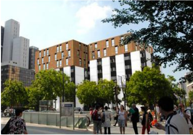
FIGURE 8.3 – FAÇADE DU FOYER C AVEC SURELEVATION
