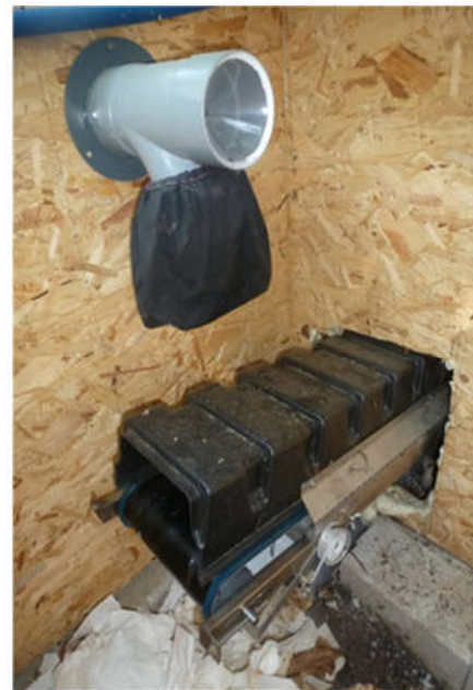
Figure 4.17 : Toilette à séparation d'urine à tapis roulant.
