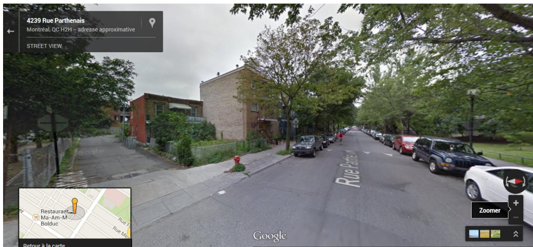
Photo 1 - Duplex du 4239 rue Parthenais, Montréal, avant sa démolition (Google Street View, 23 avril 2014).
