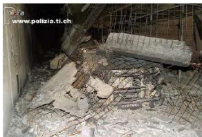
Tunnel du Saint-Gothard, Suisse
