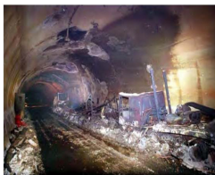
Tunnel du Mont Blanc, 1999
