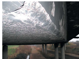
Viaduc à Falkenberg, Suède, 2005
