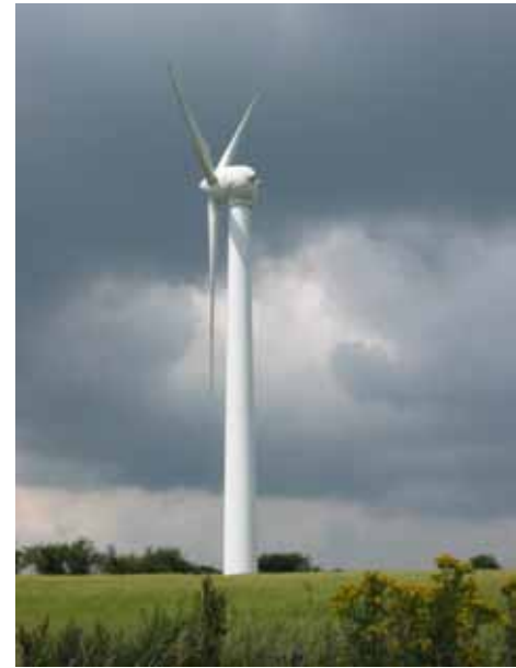
Eolienne Jeumont J48, ferme de Plougras (Bretagne)
