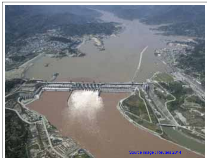
3 Gorges (Chine) 22,5 GW – 100 TWh/an (la plus grande centrale du monde en puissance et en énergie)
