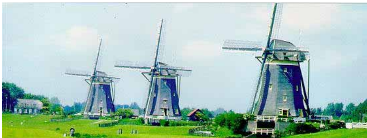
Pompage dans les polders (Hollande)
