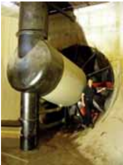
Exemple 2 unités de 1 MW (150 tr/mn, diamètre 2,6 m) à Paullo (Italie) en 2004
