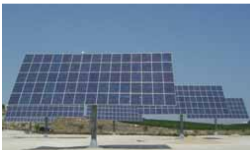
Ferme PV Caravaca de la Cruz (Espagne) 210 modules de 10,5 kW (gain 45% par rapport à orientation fixe)
