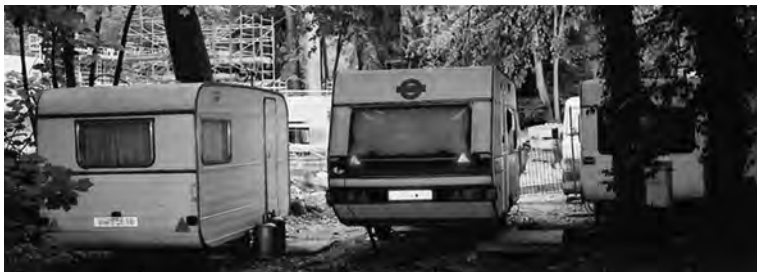
Figure 5. Chantier station d'épuration avec caravanes.
