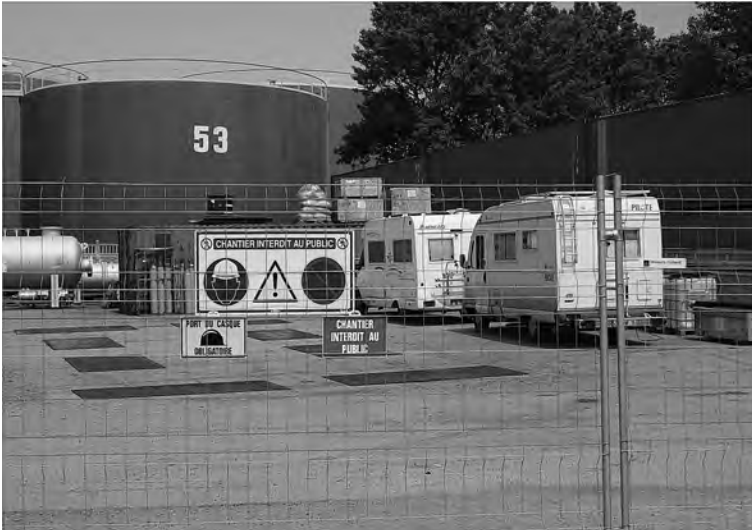
Figure 7. Chantier de construction modulaire pour l'industrie du gaz et camping-cars.
