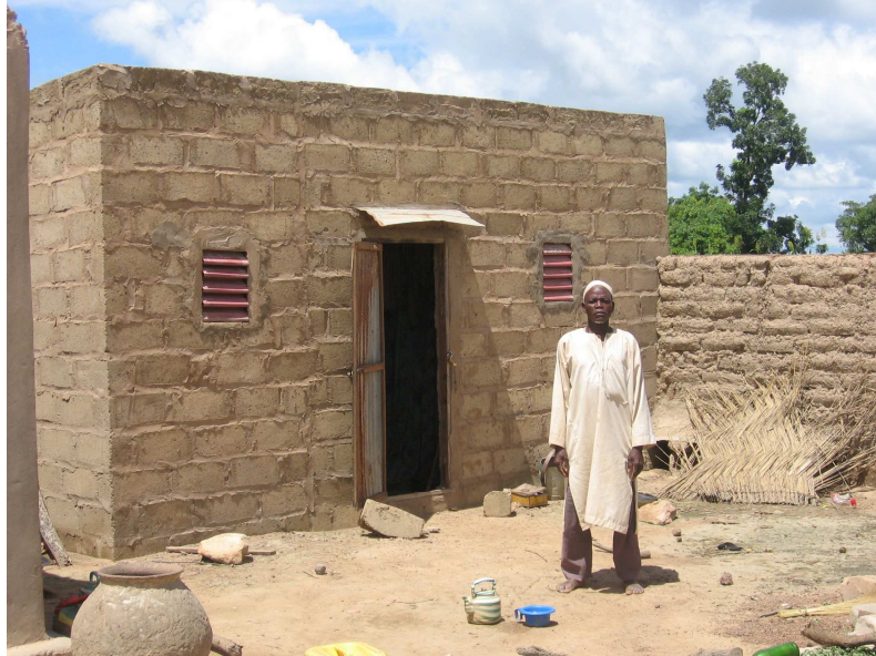
Tanghin : Nouvelle construction en briques cuites dans la concession après l'inondation
