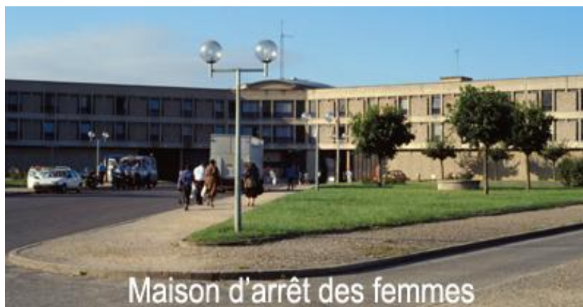
Entrée principale de la maison d'arrêt des femmes. Photo : Ministère de la justice.
