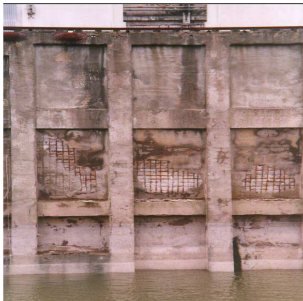
(a) quai en zone de marnage (France).
