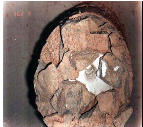
Photo 3.29 : Epreuve injectée de chaux avant surfacage
