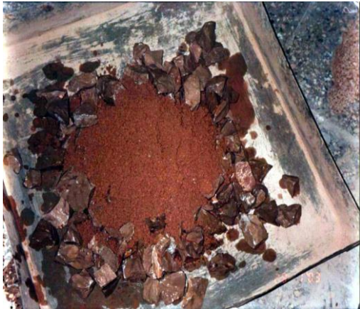
Photo 3.18 : Mélange du mortier aux cailloux
