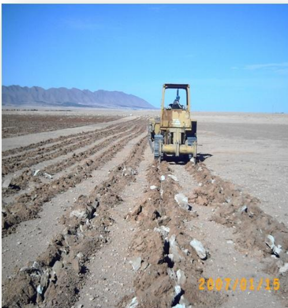
A) Travaux du sol (Sillonnage)
