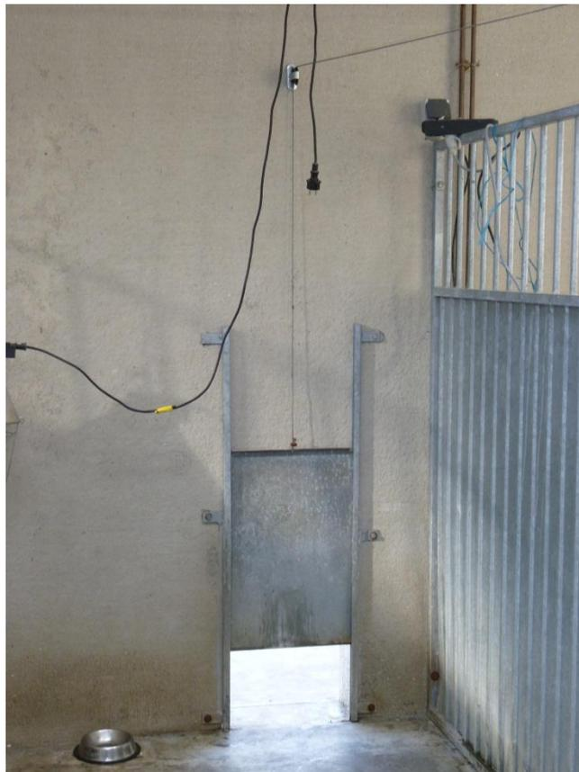
*Système de porte guillotine avec poignée d'ouverture à l'extérieur du box.*
