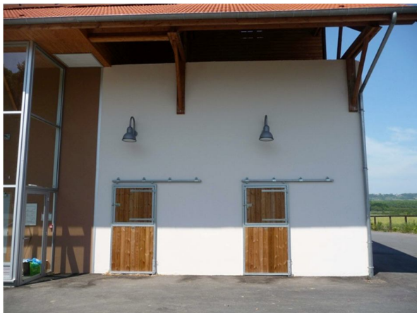
Photographie n° 7: Les box vus de l'extérieur
