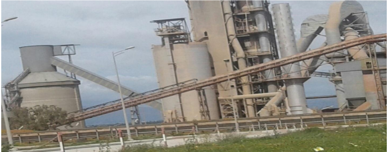
Figure 12 : Le convoyeur à bande inclinée.
